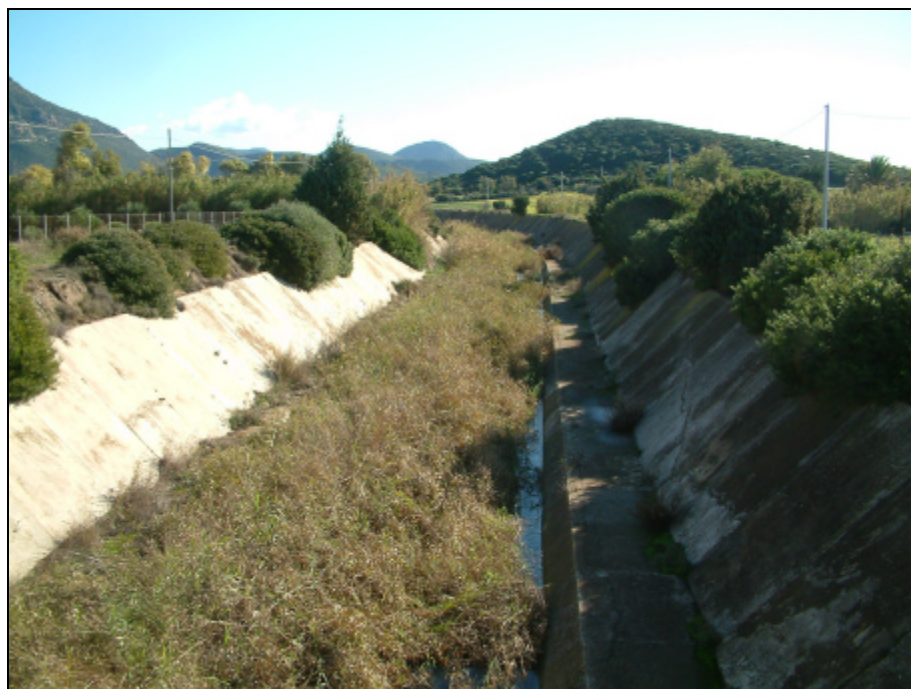
Foto 8 – Vista verso monte del tratto canalizzato di sbocco al mare: la gaveta è densamente ricoperta da canne palustri (SB006).
