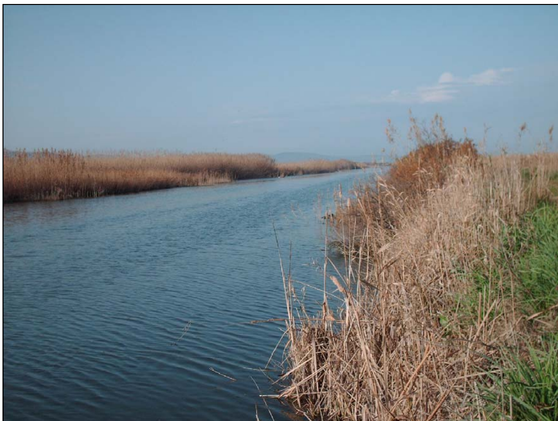
Foto 1 – Vista da monte del tratto terminale del Flumini Mannu di Pabillonis – Si osservi la conformazione artificiale con sponde rettificate e completa assenza di barre o vegetazione nel letto.
