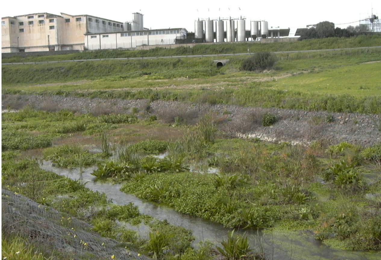
Foto 1 – Settore oggetto di interventi di risagomatura e di ricalibratura della sezione d'alveo con rivestimento del fondo e delle sponde con materassi Reno
