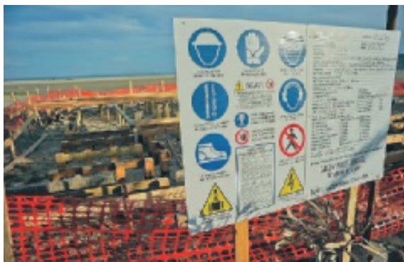
IL CANTIERE I lavori per l'ultima ricostruzione dei baretti, l'inverno scorso
