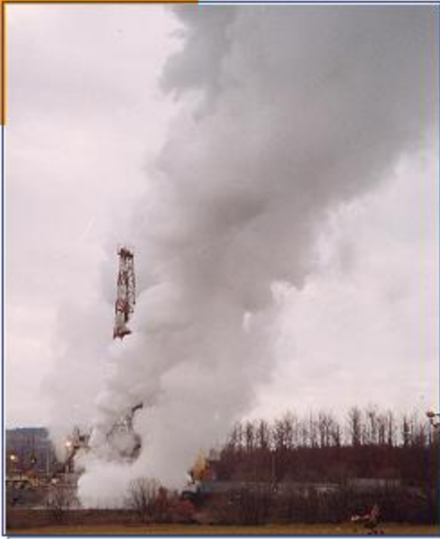
Pozzo di produzione
